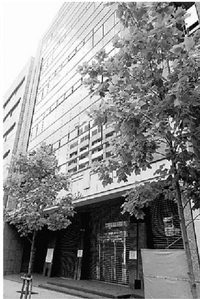
解体してビジネスホテルとなる元日本漢字能力検定協会本部ビル（京都市下京区烏丸通松原下ル）
